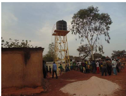
Le château d'eau
