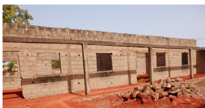
Travaux à l'Ecole B1
